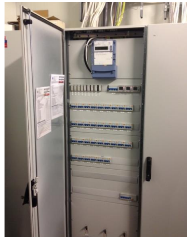
Installasjon på Rema1000 Selnes
